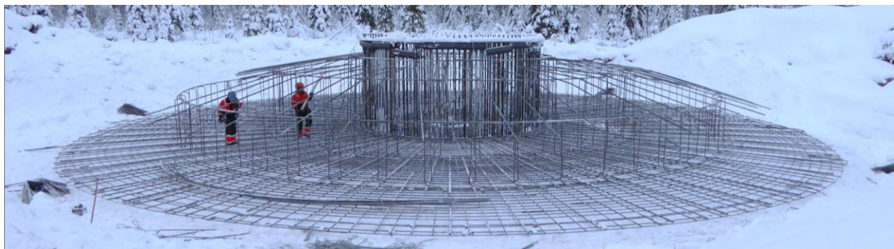
Bild 1: Armering av vindkraftverkets fundament
